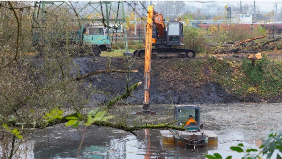
2. Intervention sur les marais en novembre 2023 : un véhicule amphibie rabat les boues vers la berge, où une pelle mécanique s'en saisit pour les stocker dans un camion monté sur chenilles
